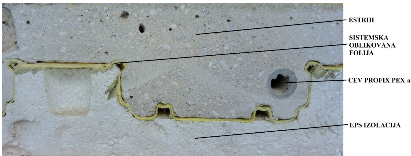
DEJANSKA ZALITOST CEVI Z ESTRIHOM V SISTEMSKI PLOŠČI PROFIX DO 100%
