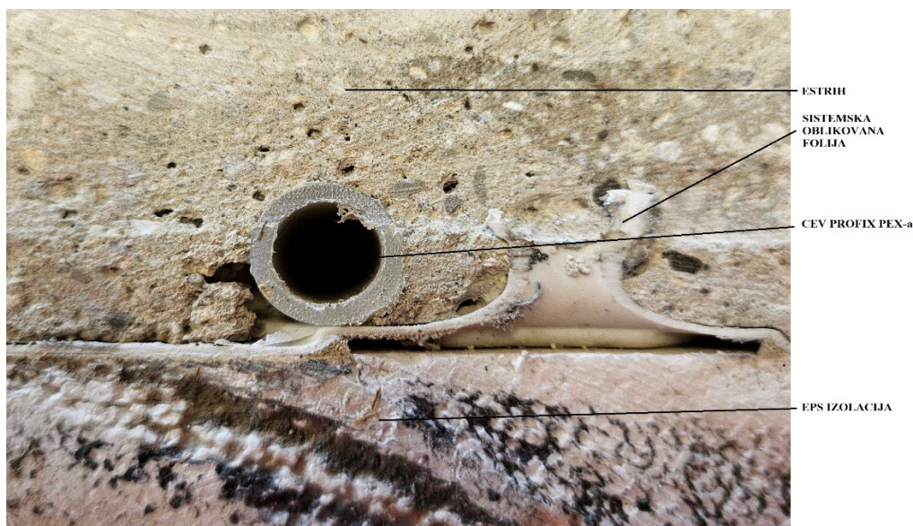
DEJANSKA ZALITOST CEVI Z ESRIHOM V SISTEMSKI PLOŠČI STANDARD
