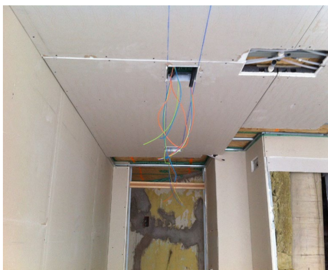
Sistem modularnih plošč izvedba stropnega ogrevanja in hlajenja
